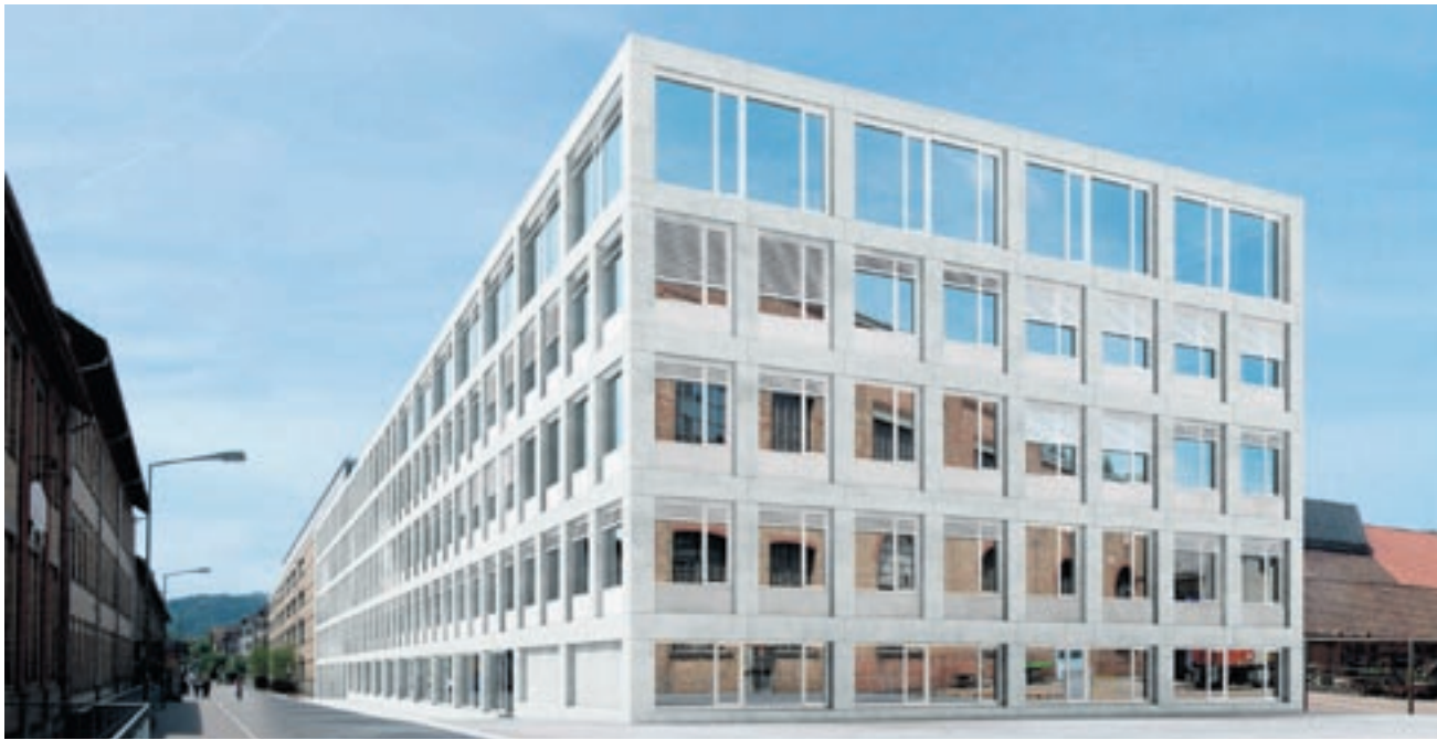
Anfang 2010 soll der von Winterthurer und Zürcher Architekten entworfene Technopark-Anbau fertig sein. Computermodell: pd
