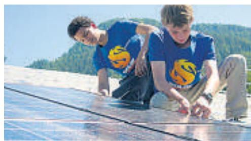
August 2004. JugendSolarProjekt in Feldis GR, Montage von Solarstromanlage auf Stalldach. Internationales Camp mit Teilnehmenden aus 7 Ländern (Deutschland, Frankreich, Holland, China, Mongolei, Schweiz, Mexico).
