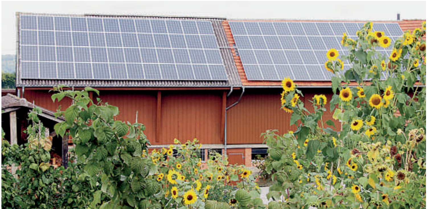
Solarenergie im Trend: Der Bau von Fotovoltaikanlagen wird in den Kantonen Zürich und Thurgau mit verschiedensten Förderprogrammen unterstützt.
