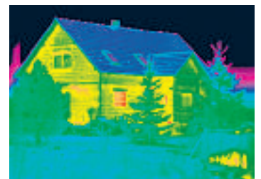
Energielecks: Wärmebilder zeigen sie.
