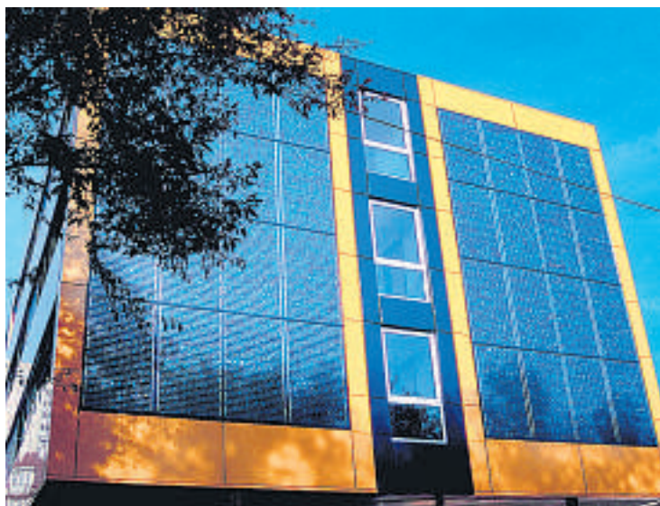
«energie bewegt» und treibt die technischen Entwicklungen stetig voran: Fassaden-Fotovoltaikanlage in Lausanne. Bild: Schweizerische Vereinigung für Sonnenenergie SSES
