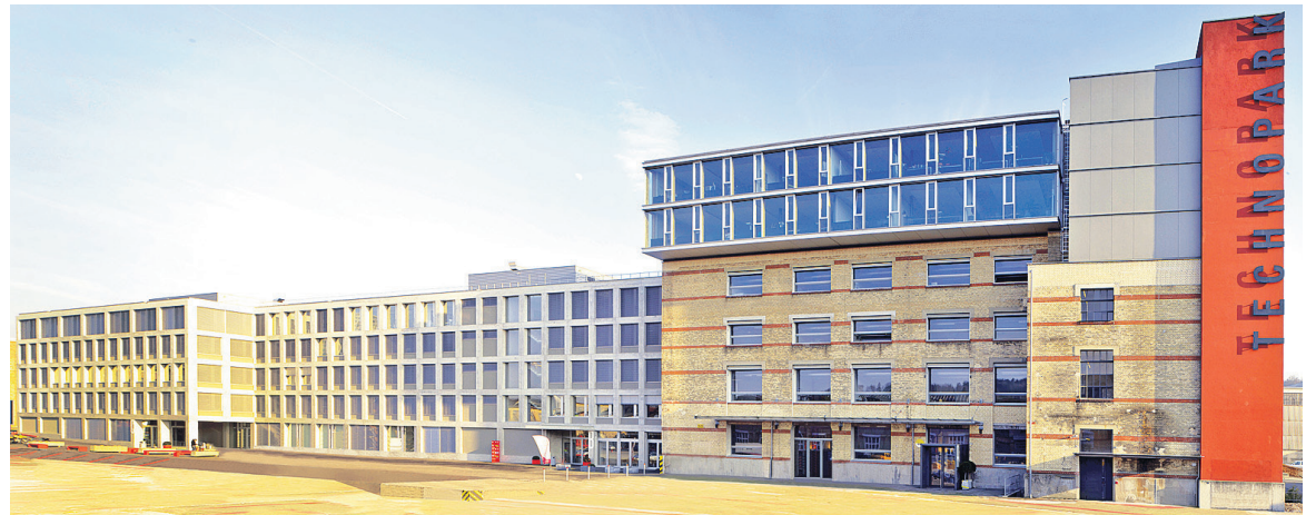
Mit der Realisierung des Neubaus 2010 (links) stieg die vermietbare Fläche des Technoparks von 4000 auf 10 000 m 2 . Bilder: pd.
