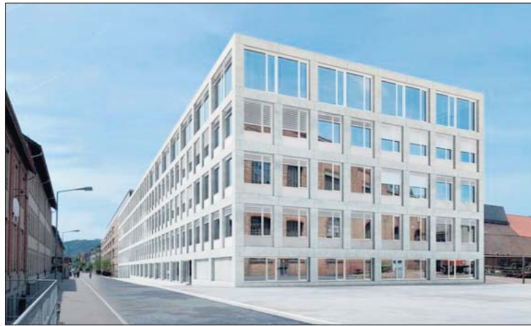
Der Anbau am bestehenden Gebäude.
